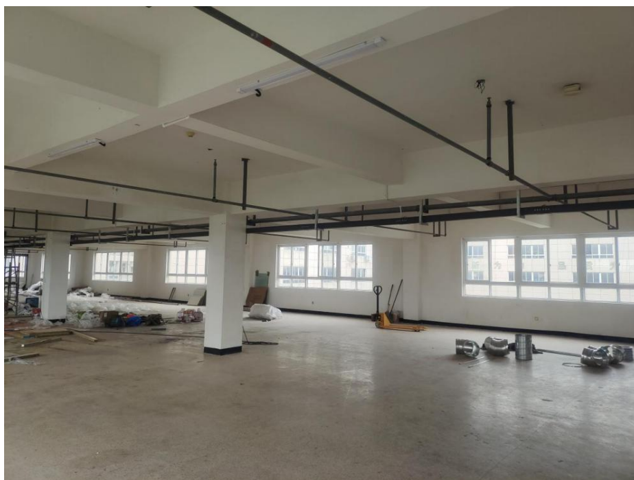
图 2-3 现场空置照片
